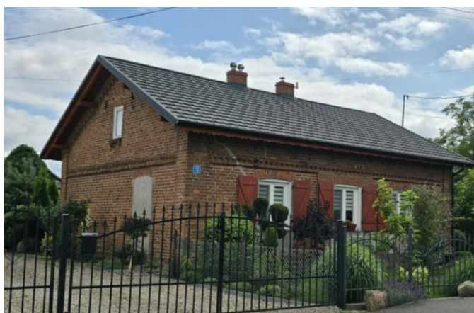
Fotografia 10. Przykład zabudowy z czerwonej cegły licowej w miejscowości Węgiersk (po przeprowadzonej modernizacji pokrycia dachowego)
