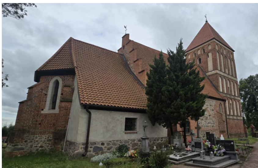
Fotografia 2. Widok na Kościół pw. św. Marcina we Wrockach
