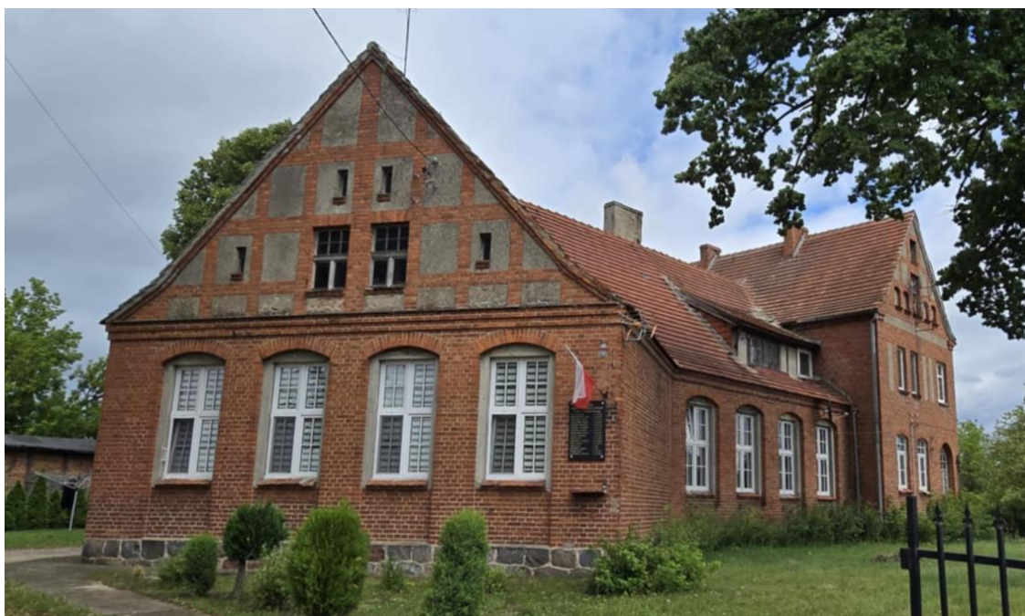
Fotografia 6. Widok na budynek dawnej szkoły w miejscowości Podzamek Golubski
